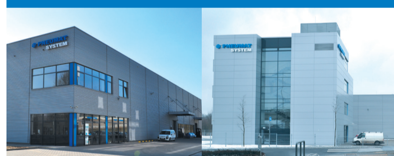
Nowa siedziba firmy przy ul. Obornickiej 160 we Wrocławiu
